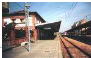
ESTACION DE TREN
